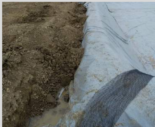
Fixation dans une tranchée d'ancrage existante de 0.50x0.50m
